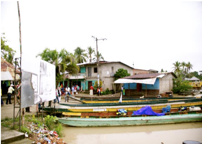
Fotografía 91: Muelle de Paimadó
