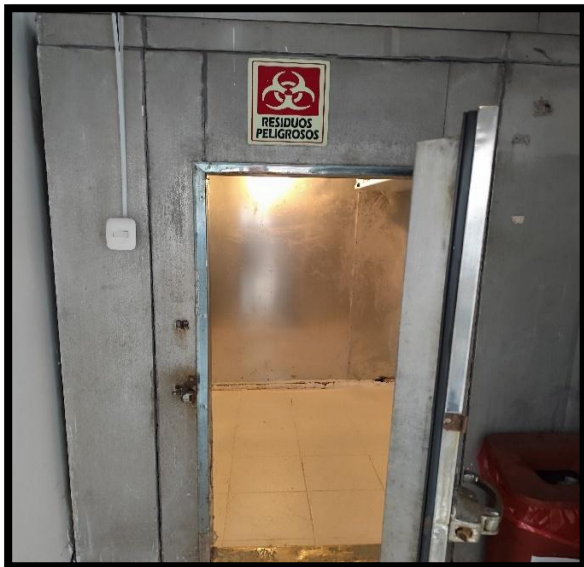
Fotografía 15. Puerta de acceso exterior al Cuarto Frío 2 (Residuos Peligrosos).
